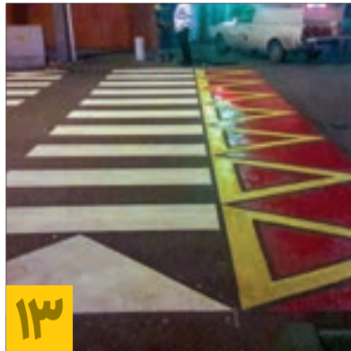
اصلاح هندسی و روکش آسفالت چهارراه لشکر
