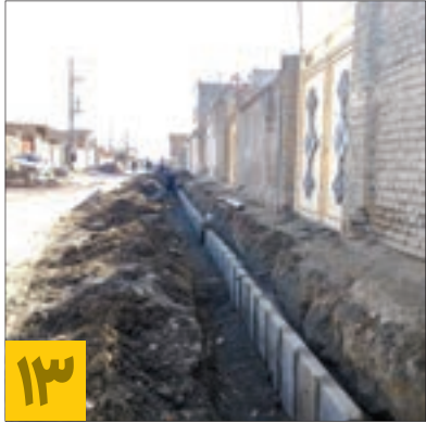
احداث کانال جمع آوری آب های سطحی در بولوار شاهنامه
