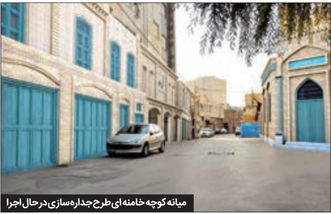
میانه کوچه خامنه‌ای طرح جداره‌سازی در حال اجرا
