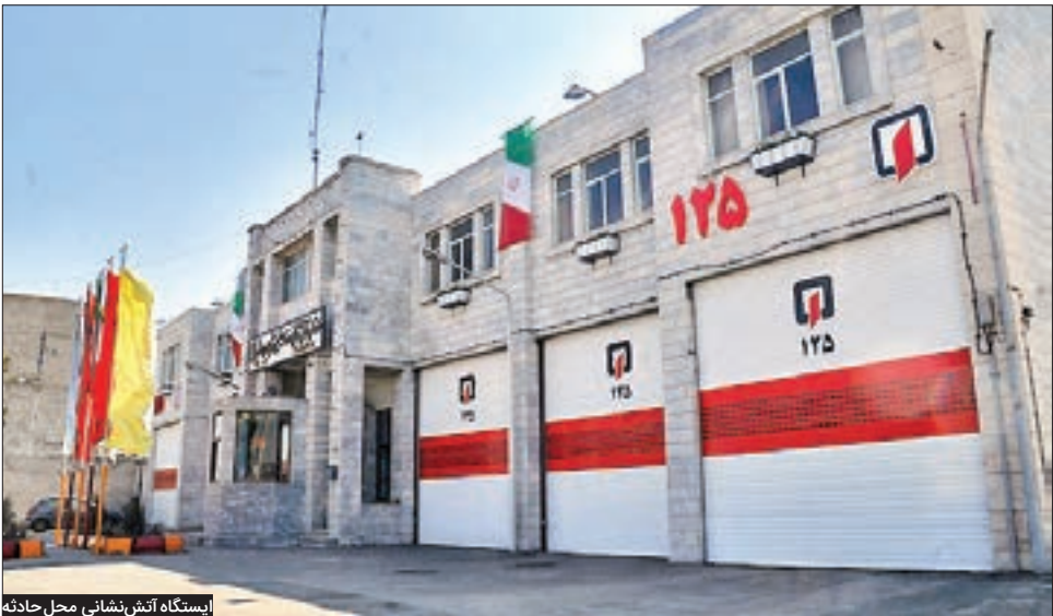
[بستگاه آتش‌نشانی محل حادثه]
