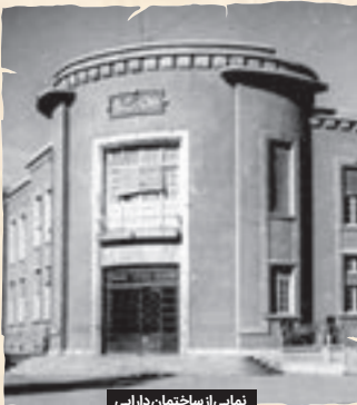
نمایی از ساختمان دارایی
