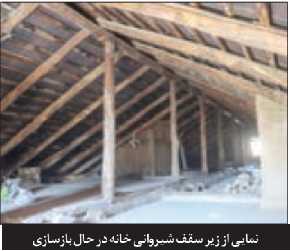
نمایی از زیر سقف شیروانی خانه در حال بازسازی
