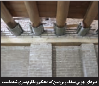
تیرهای چوبی سقف زیرزمین که محکم و مقاوم سازی شده است
