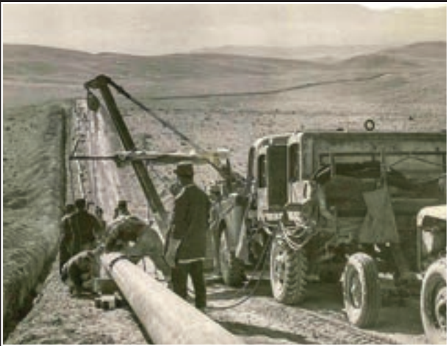
تصویری از عملیات لوله‌گذاری به سمت شیراز
