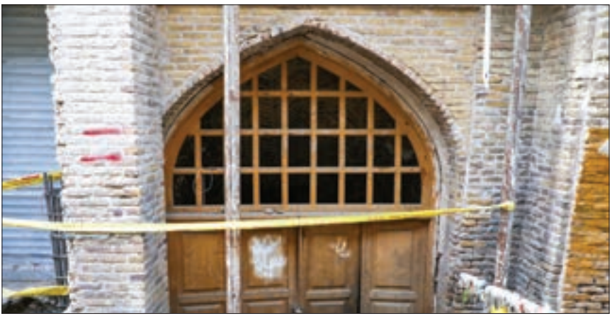
آب‌انبار قدیمی کوچه چهل پایه
