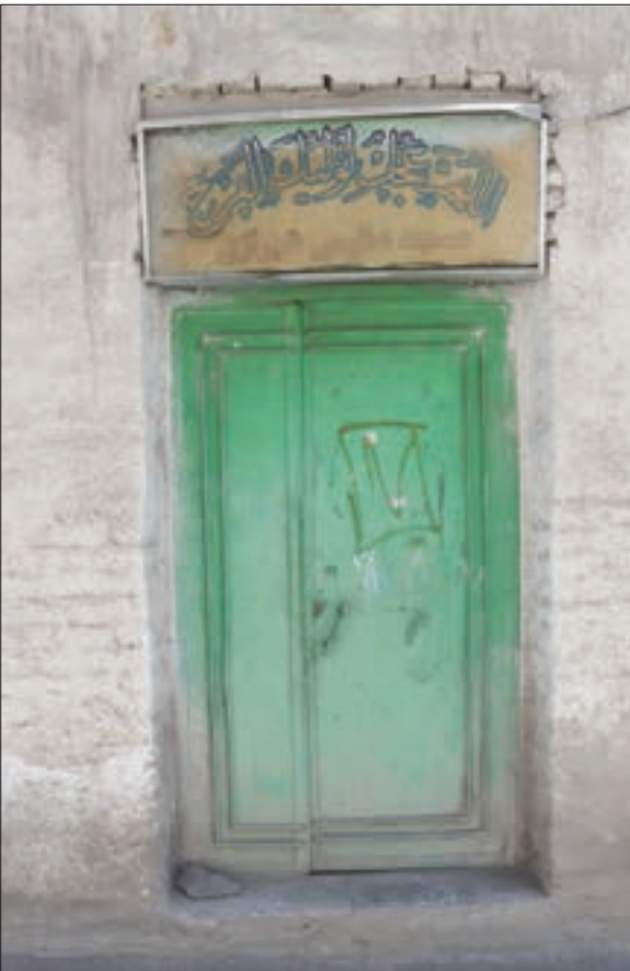
نمایی از تابلو و در مسجد خورده
