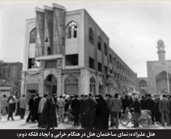
هتل علیزاده (نمای ساختمان هتل در هنگام خرابی و ایجاد فلکه دوم)
