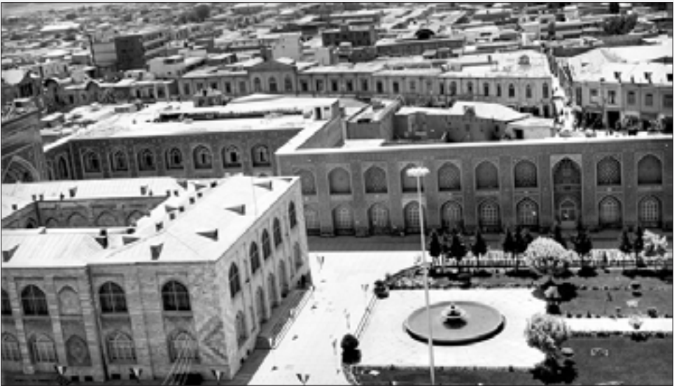
نمای بیرونی ساختمان قدیم موزه آستان قدس رضوی
