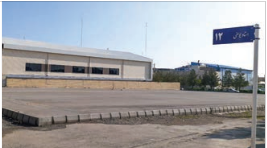
زمین ورزشی خیابان استاد یوسفی بعد از تخریب
