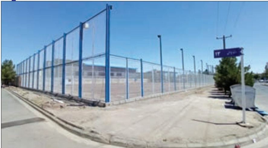
زمین ورزشی خیابان استاد یوسفی قبل از تخریب
