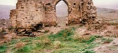
نمای از ضلع شمالی بنا
