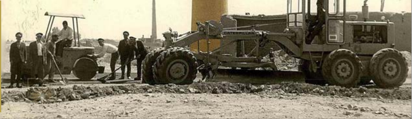
ساخت و ساز در کنار کوره آجر پزی / مشهد دهه ۵۰ قرن ۱۴ خورشیدی
