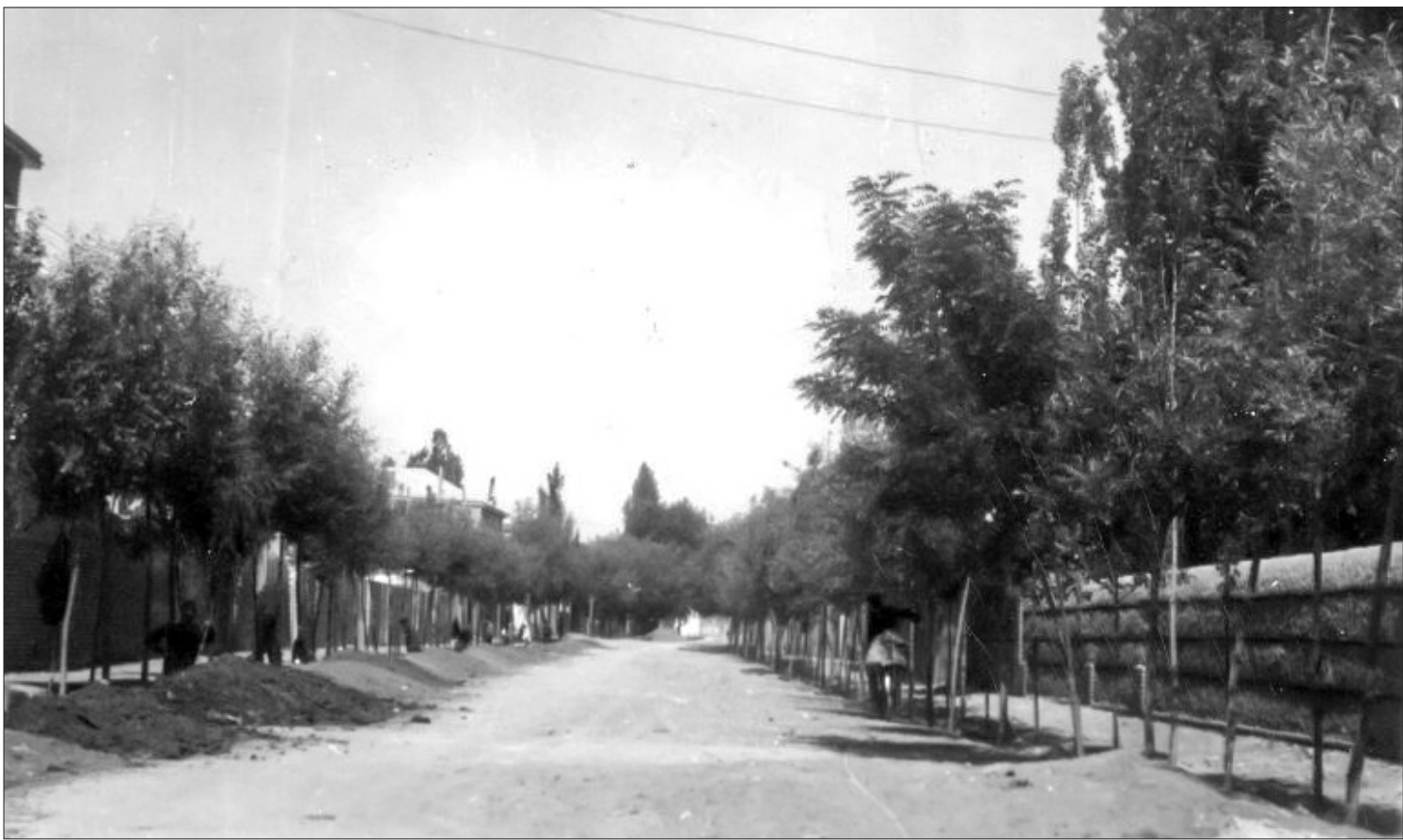
نمایی از باغ های اندشت که کارگران در حال کندن آن برای احداث خیابان کره‌شنگی هستند.
