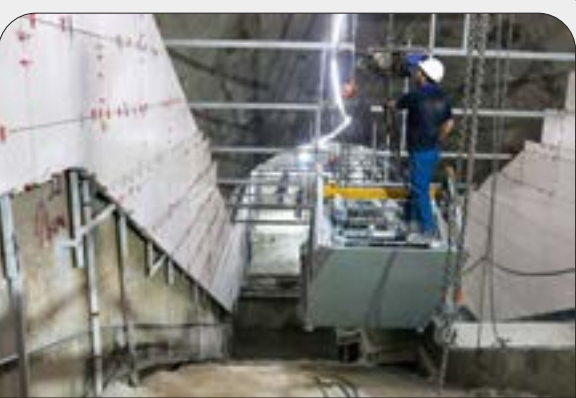
آغاز عملیات نصب پله برقی‌های مسیر خط ۲ به ۳ ایستگاه میدان شهدا
