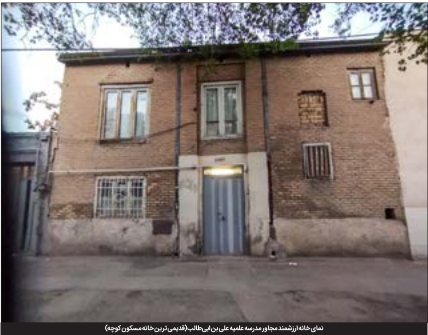
نمای خانه از شند مجاور مدرسه علمیه علی بن ابی‌طالب (قدیمی‌ترین خانه مسکون کوچه)
