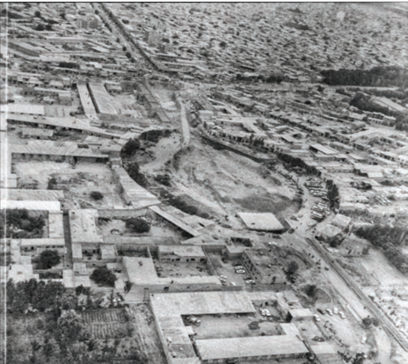
عکس هوایی از پروژه تقاطع غیرهم‌سطح پنجراه پایین‌خیابان
