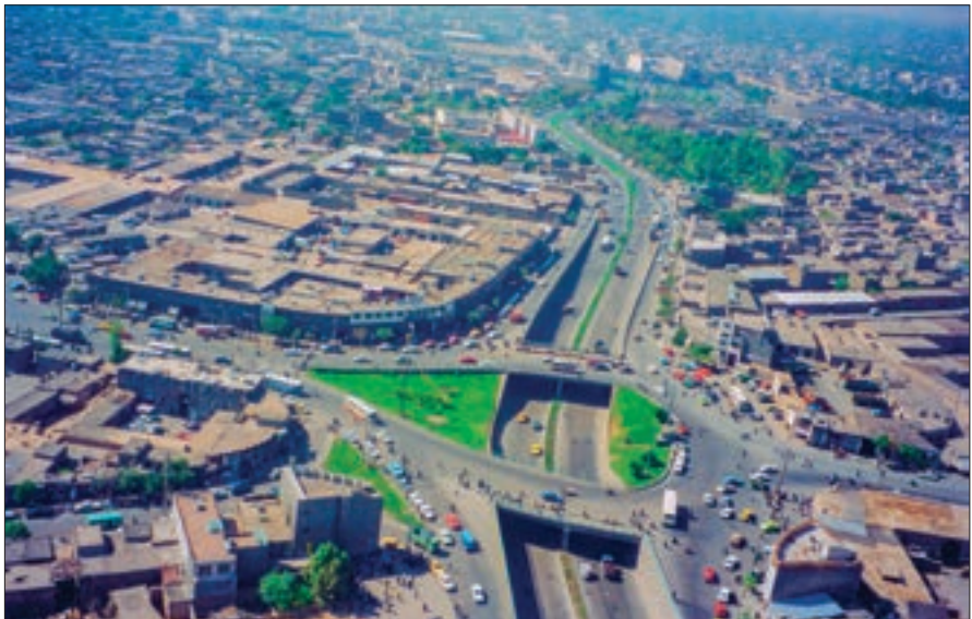
تقاطع غیرهم‌سطح پنجراه پایین‌خیابان در سال‌های اخیر
