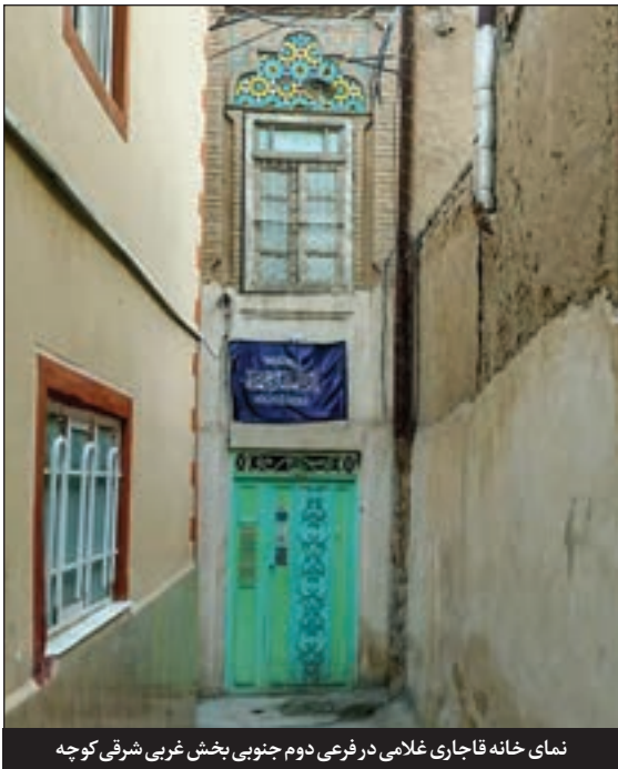
نمای خانه قاجاری غلامی در فرعی دوم جنوبی بخش غربی شرقی کوچه
