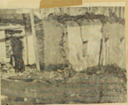
منظره خرابی منزلی در خیابان سی متری
