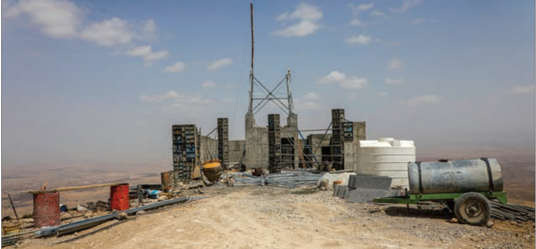
روی قله احتمالا برای ساخت دکل بتن ریزی و مسطح شده است.
