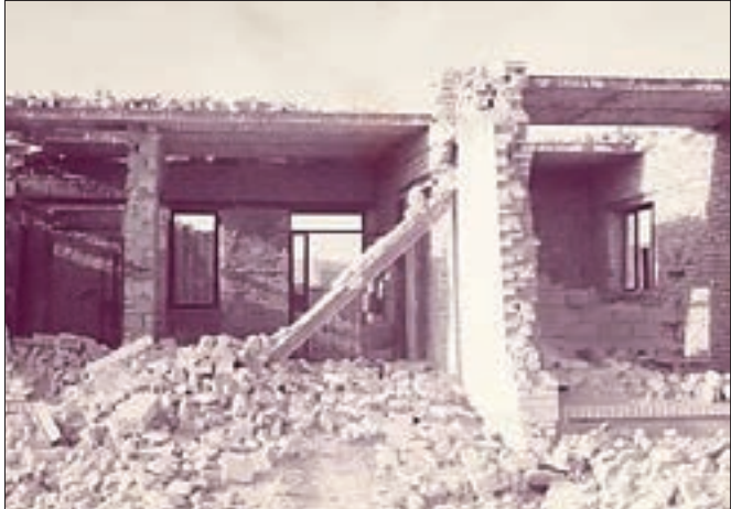
یکی از ساختمان‌های کارگاه هویزه که بر اثر انفجار موشک تخریب شد. عکس از سید حسن مجرمیان
