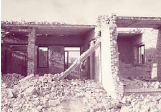
یکی از ساختمان‌های کارگاه هویزه که بر اثر انفجار موشک تخریب شد. عکس از سید حسن مجمریان
