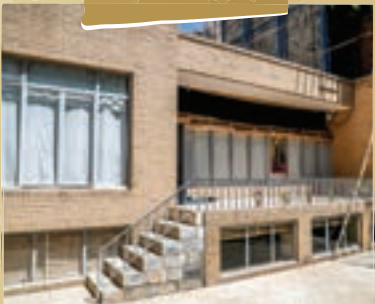
نمایی از ساختمان خانه رهبر شهید انقلاب اسلامی
