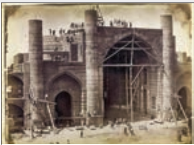
مسجد سپهسالار در حال ساخت. حدود ۱۳۰۰ قمری
