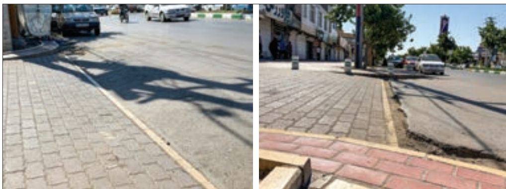
پیاده‌روسازی جدید بولوار حر باعث اختلاف سطح بین خیابان و ورودی کوچه‌ها شده است
