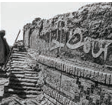
نمایی از ساقه گنبد مسجد گوهرشاد در زمان بازسازی اساسی دهه ۱۳۴۰ خورشیدی
