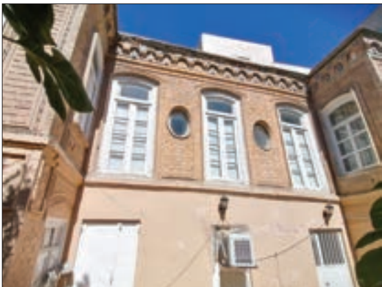
نمای امروزی ساختمان از داخل حیاط
