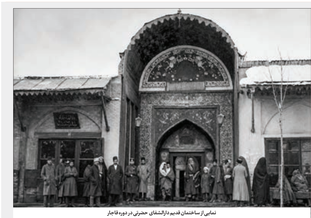
نمایی از ساختمان قدیم دارالشفای حضرتی در دوره قاجار
